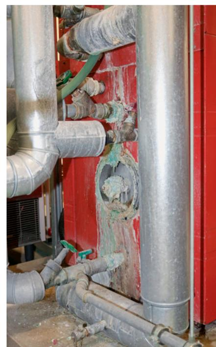
Ungepflegte Einbauteile fördern eine mikrobielle Verkeimung. Foto: A. Bürschgens
