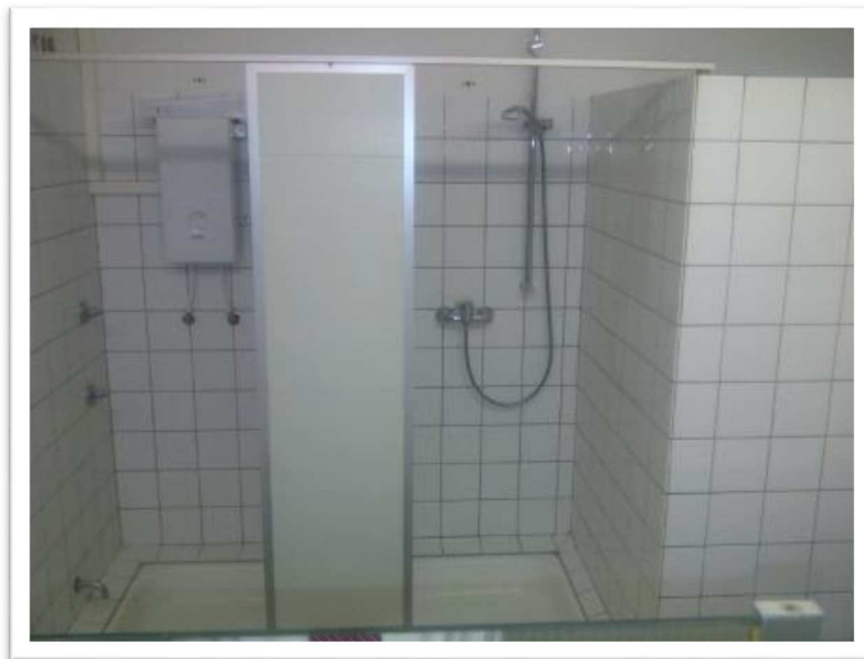
Zwischenstand der Umbauarbeiten
