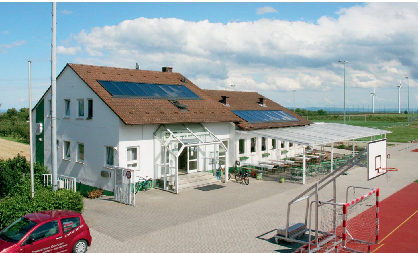
Auch am Vereinsheim des TSV Zornheim wurden im Jahr 2018 energetische Neuerungen vorgenommen. Foto: LSB Archiv
